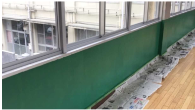
【2階廊下壁のペンキ塗り】
