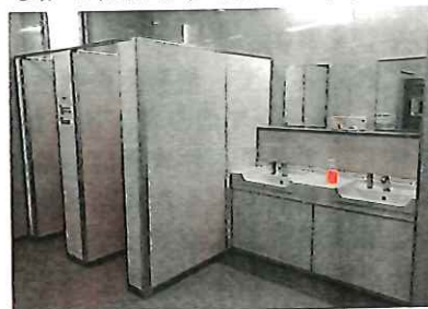
【完成したトイレ】
