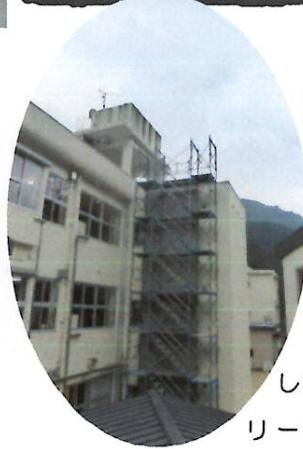
一連の熊本地震で大破の判定を受け、壁に亀裂が走った塔屋(屋上に上の部分)の修復工事が始まりました。一足先に応急補修が完了した希望坂横のコンクリート階段は、雪が降る前に通行可能となり、安心・安全な登校路が確保できて、ほっとしています。
